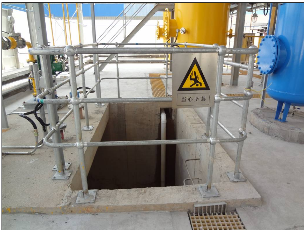
附图 7 液氮供应系统区污水池
