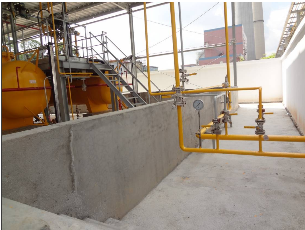
附图 5 液氨储罐围堰和外围墙
