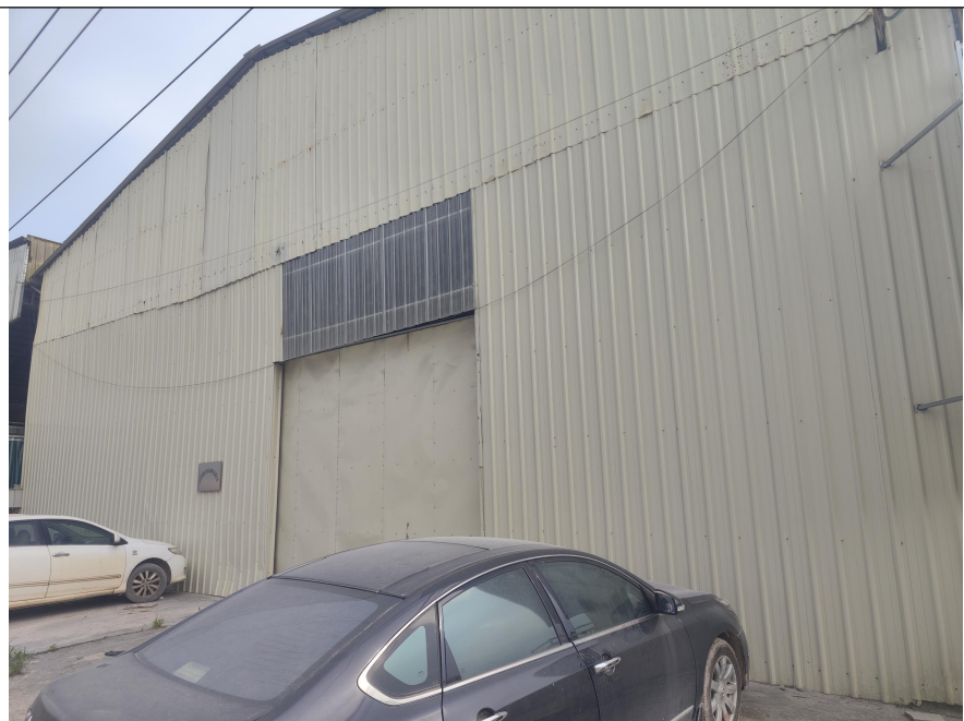
项目东南侧云浮爱瑞特无机石材科技有限公司
