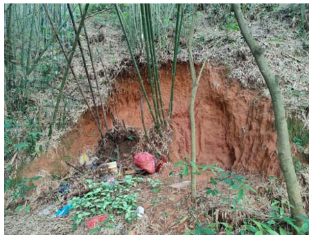
照片 20 现状崩塌 BT5（镜向 NW）
