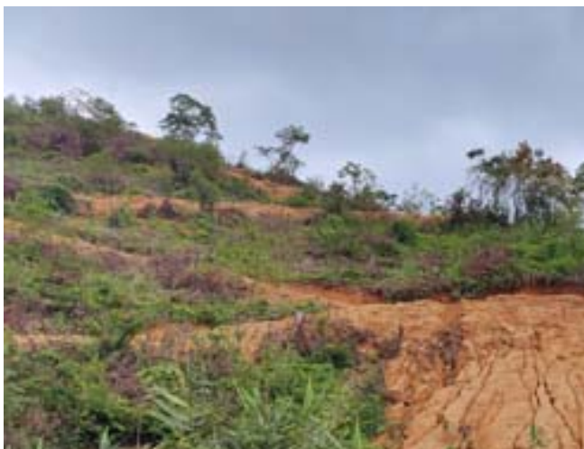
照片 1 百石大道终点南侧自然斜坡现状（镜向 SE）
