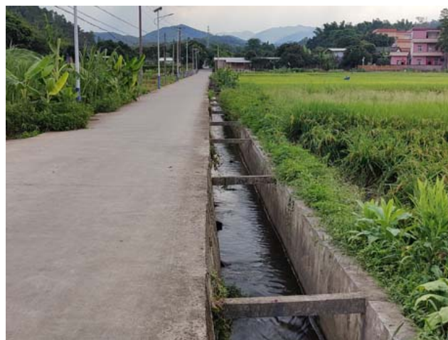
照片 28 场地北部村道及排水沟（镜向 W）
