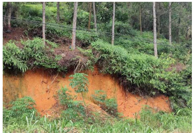
照片 18 现状崩塌 BT3(镜向 NW)
