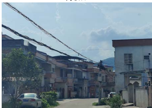
照片 12 场地西南侧都滂村现状（镜向 SE）
