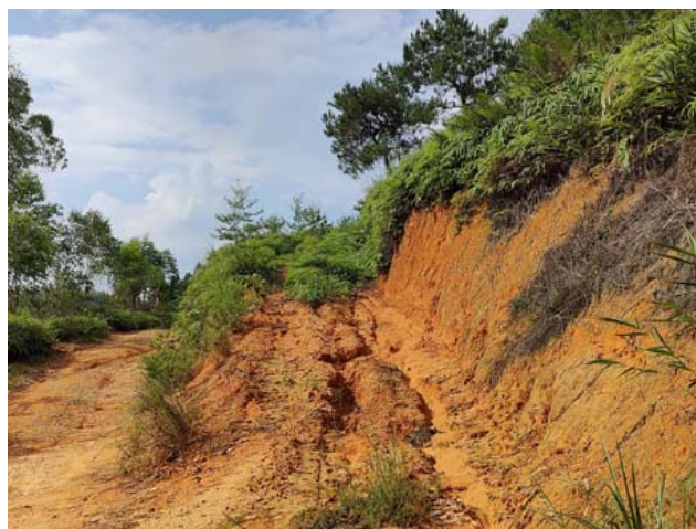
照片 2 百石大道终点处现状概貌（镜向 N）
