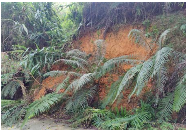
照片 3 场地南侧现状崩塌 BT1（镜向 W）
