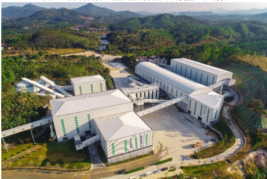
图 2-9 顺兴石场生产线现状
