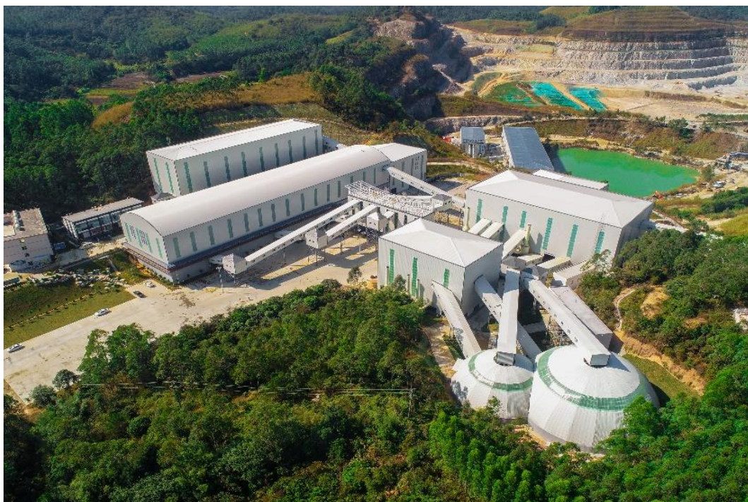
图 2-10 顺兴石场生产线现状
