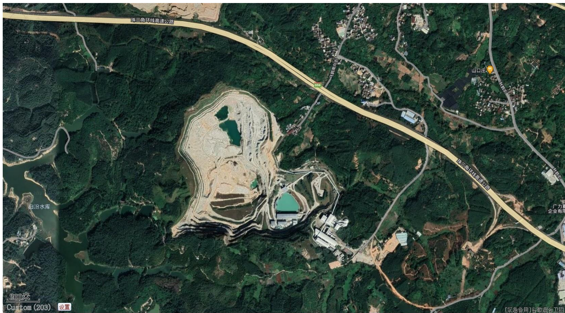
图 2-12 顺兴石场现状正射影像图
