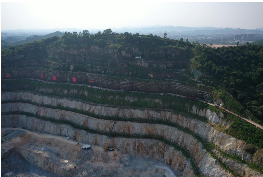
图 2-8 顺兴石场矿山露天采场台阶平台复垦工程现状
