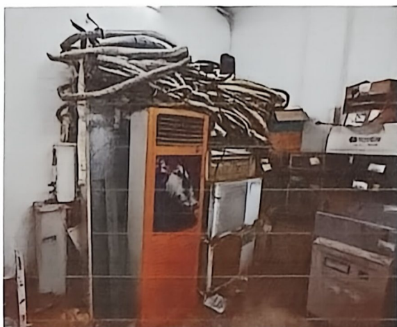
照片说明：评估对象现场照片
