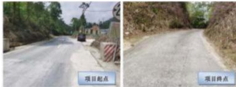
图2-1 工程起终点现状影像图
