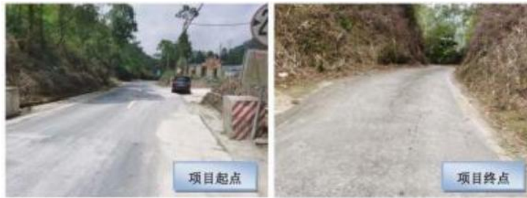
图2-1 工程起终点现状影像图
