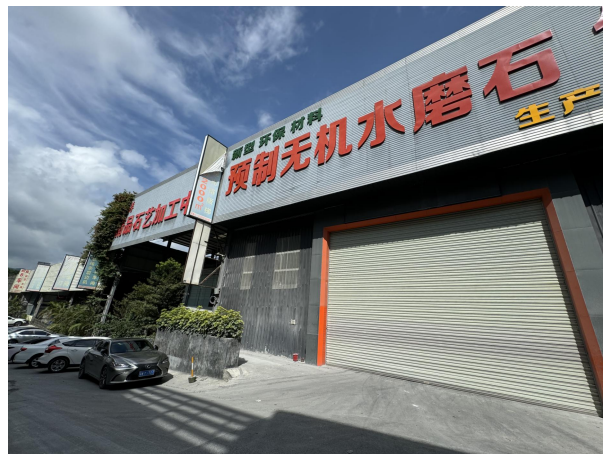
项目厂房正面图
