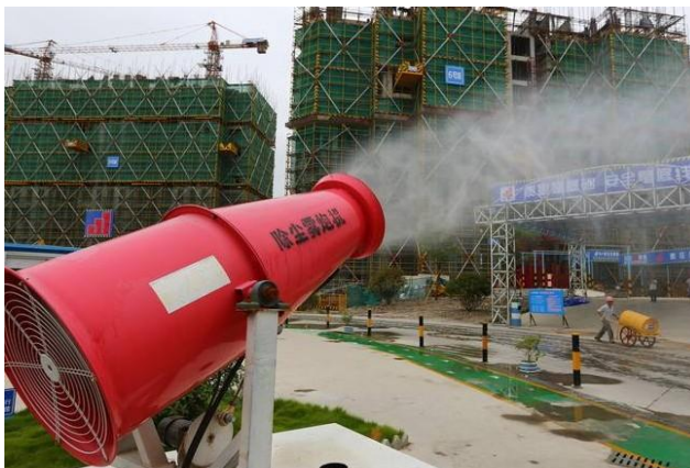
自动喷雾降尘装置示例图
