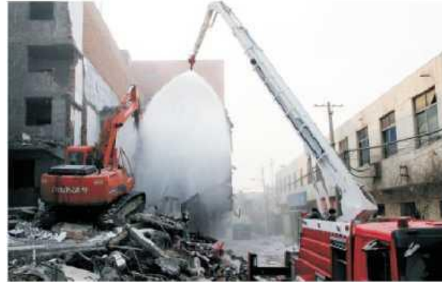
拆除工地 100%湿法作业示例图
