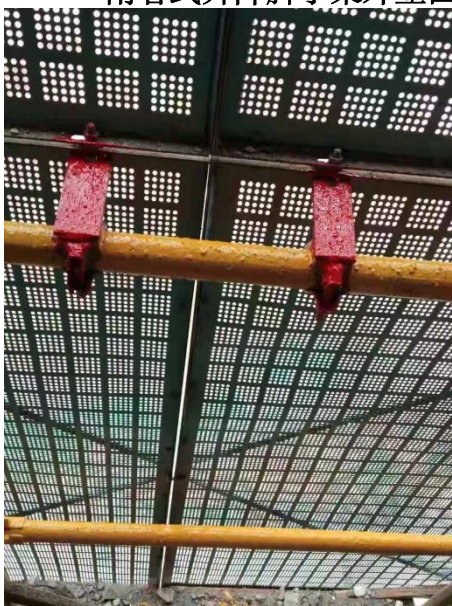
冲孔金属板安全网固定实体图
