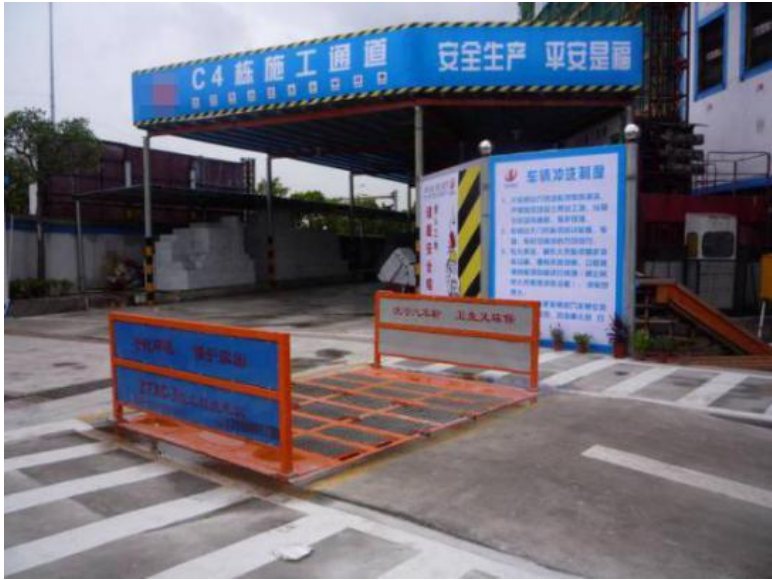
自动洗车装置示例图
