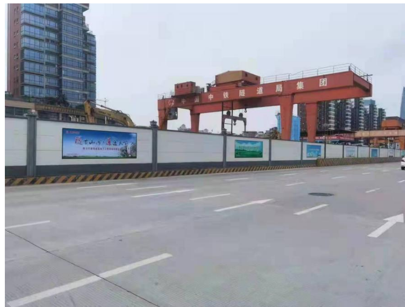
定型化、工具化围挡实物图
