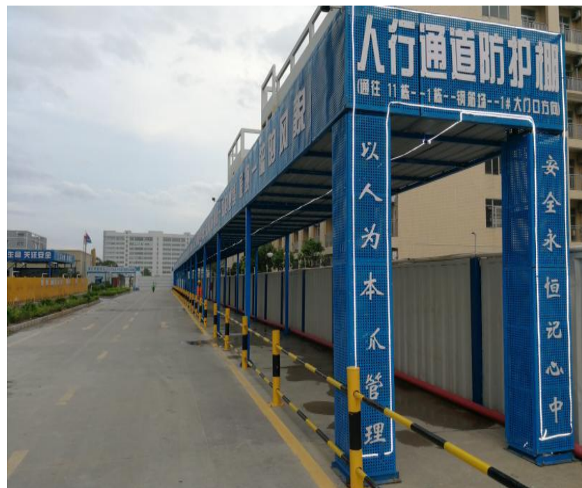
人车分流通道防护示例图
