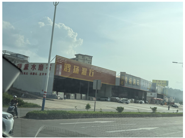
项目西北面东风村及石材销售店铺
